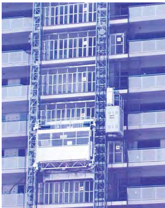
2 t 長尺ケーシング(左)と0.98 t 箱型ケーシング(右)が単独運行可能
