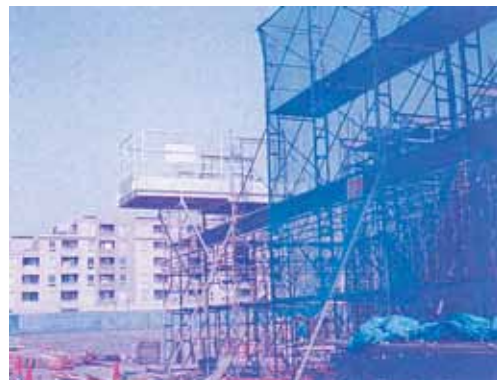
▲幕張新都心作業所：移動式荷受溝台
